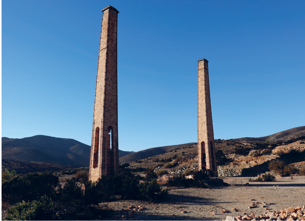
Figura 2. Chimeneas o torres de la fundición cuprífera de Labrar, fueron construidas en 1846, son las únicas de su tipo que siguen en pie en el país y son monumento nacional desde 1980. Comuna de Freirina, provincia de Huasco, región de Atacama Fuente: Fotografía del autor.
